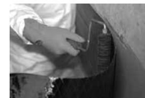
Aplicação da fibra de carbono
