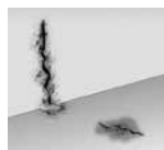
Selamento de Fissuras
